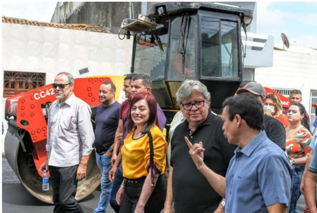
Obras de travessia urbana compreendem uma extensão de 5,4 km e recebem investimentos de R$ 3,4 milhões (Foto: José Marques/Secom-PB)
