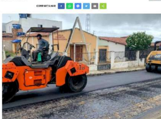
Obra de pavimentação asfáltica da travessia urbana da cidade de Caturité.
